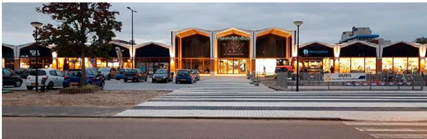
Duidelijke oversteek ter plaatse van de entree van het winkelcentrum
