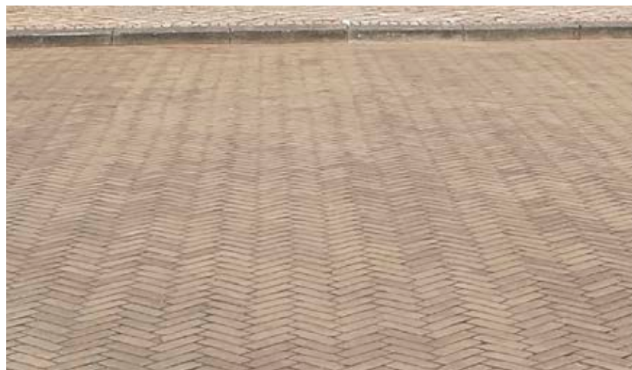
Klinkerverharding dat vrijkomt uit het Kerkplein hergebruiken in de winkelplint
