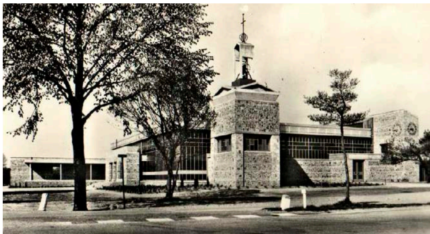
Situatie na aanleg
