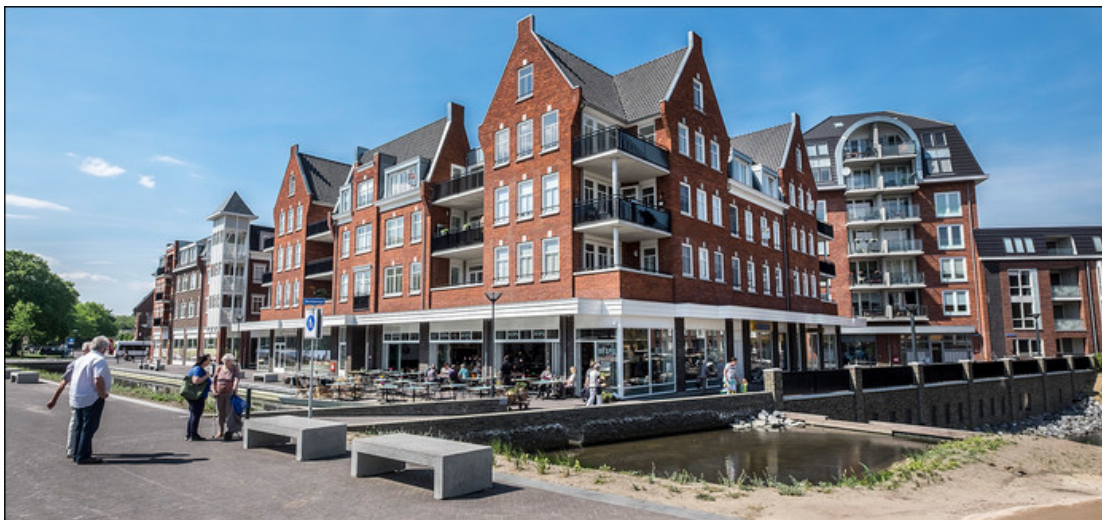
Centrum Groesbeek: nieuwbouw in het centrum draagt bij aan kwaliteit en imago.
